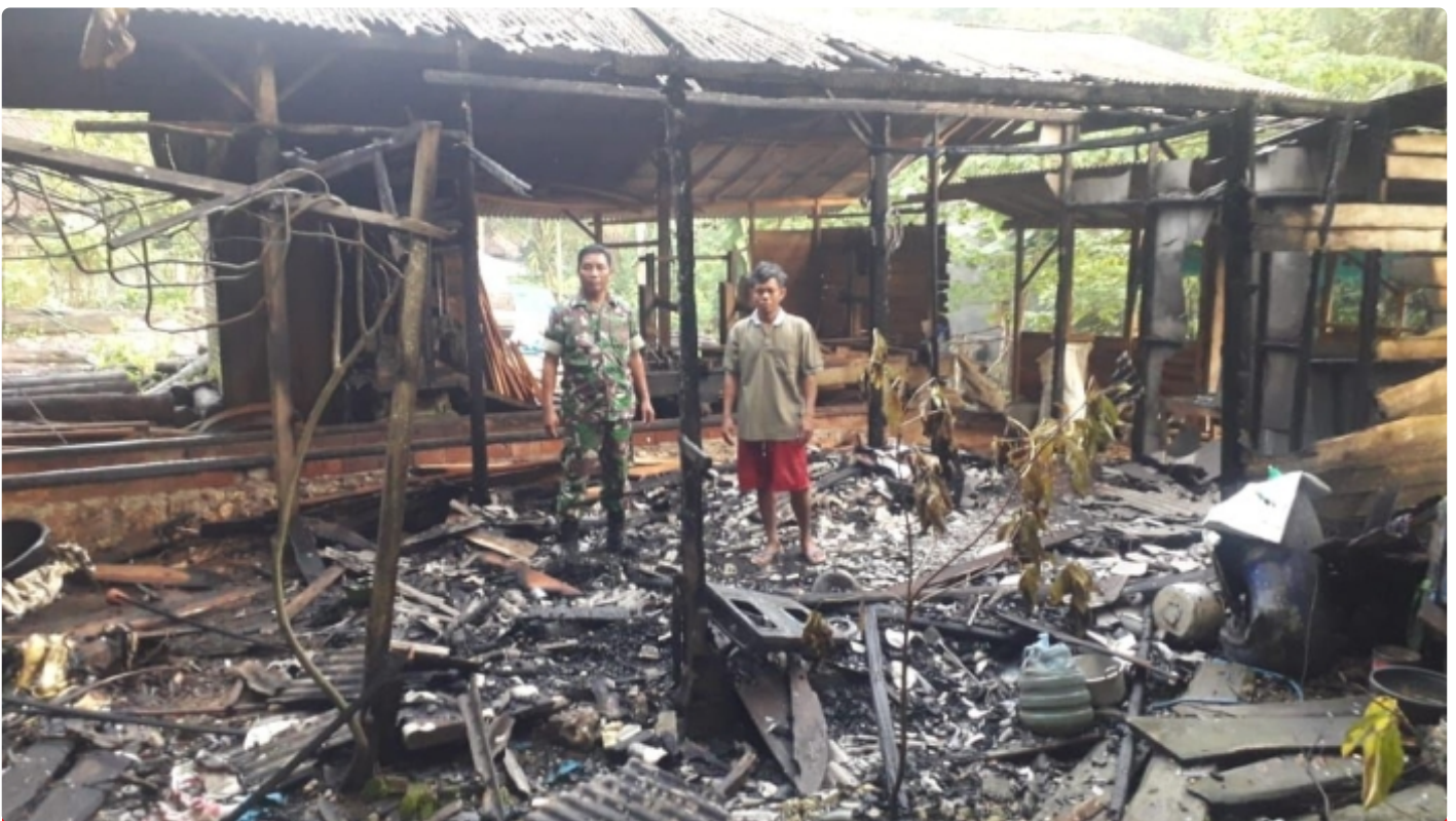
Babinsa Koramil 20/Buayan Bantu Warga Bersihkan Puing Kebakaran Rumah Warga
