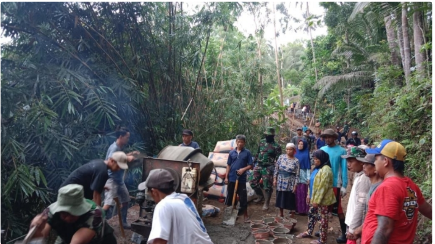
Babinsa Koramil 22/Ayah Serma Tugino bersama warga Giyanti bahu membahu membangun talud penahan bahu jalan
