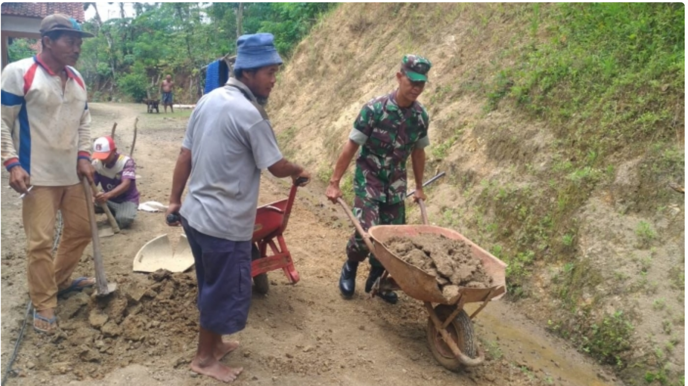
Serma Haryanto berbaur dengan warga dalam pembangunan jalan sepanjang dilingkungan RW 1 Dukuh Ketileng, Desa Donorojo,
